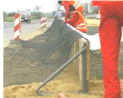
г) укладання торцевої геотекстильної прокладки
