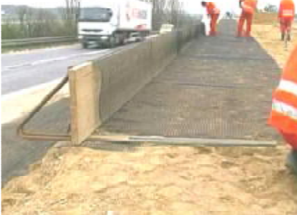
в) укладання первинного армування
