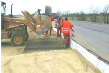
д) засипання армуючого полотна ґрунтом
