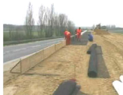
б) встановлення тимчасової опалубки
