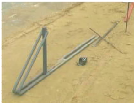
а) металевий упор опалубки
