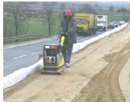
е) ущільнення торцевої частини ручною віброплитою
